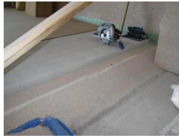
Solaio interpiano: pacchetto "a secco"
