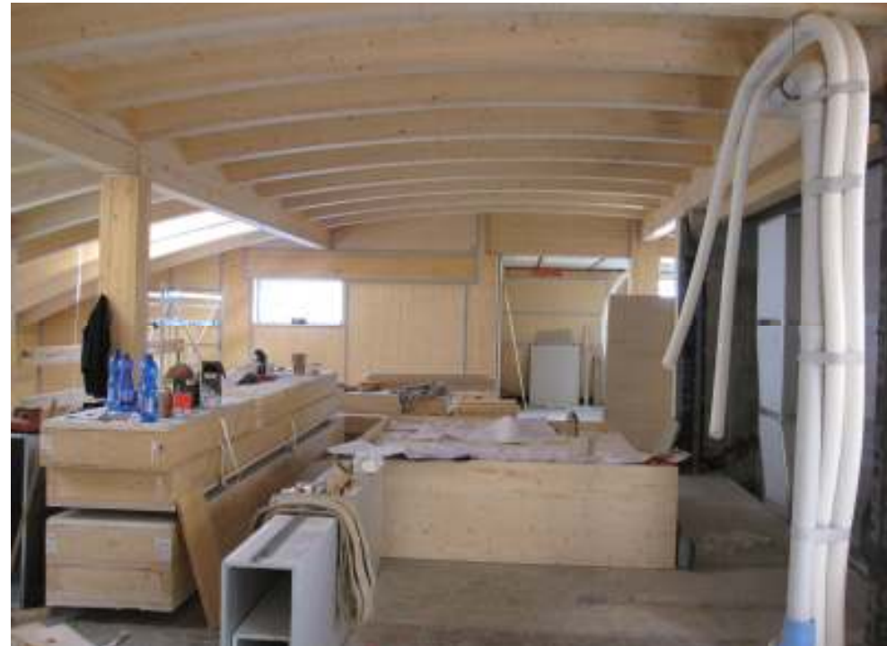
Tetto fabbricato B: volta a botte
