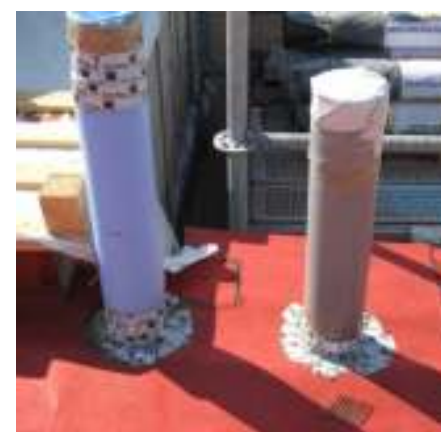
gestione attraversamenti per la tenuta all'aria
