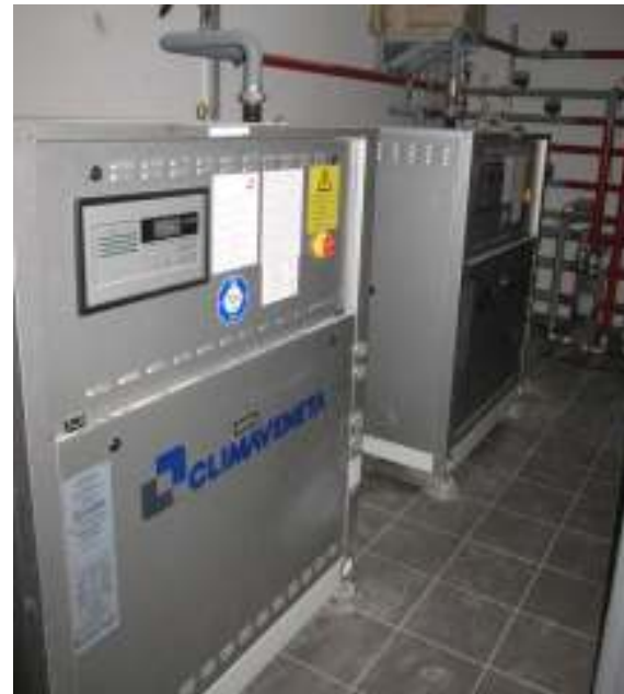
Pompa di calore –accumulatori inerziali e accumulo ACS
