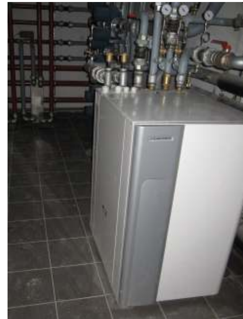
Pompa di calore –accumulatori inerziali e accumulo ACS
