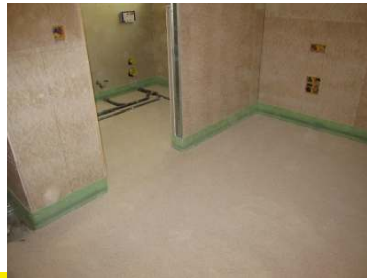
Solaio interpiano: pacchetto "a secco"
