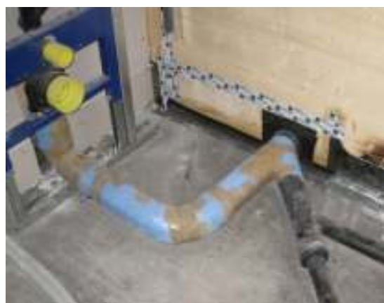
gestione attraversamenti per la tenuta all'aria
