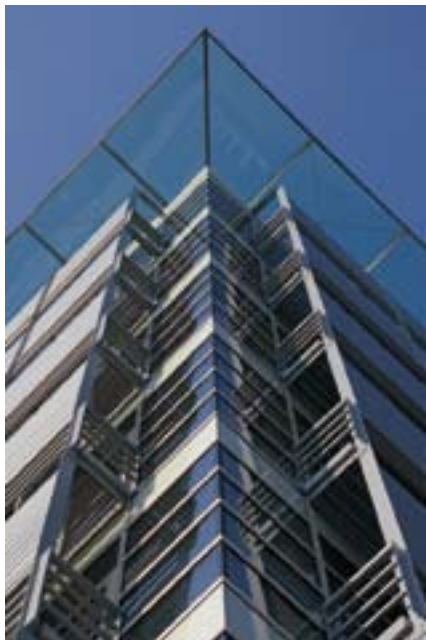
Edificio direzionale CasaClima A, Tavagnacco
